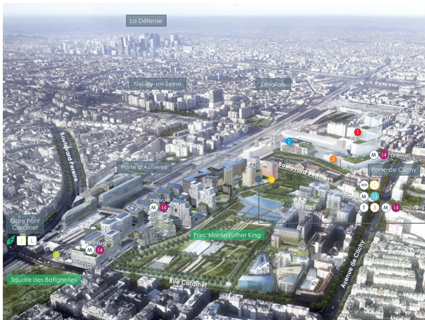
L'extension en cours du quartier des Batignolles
